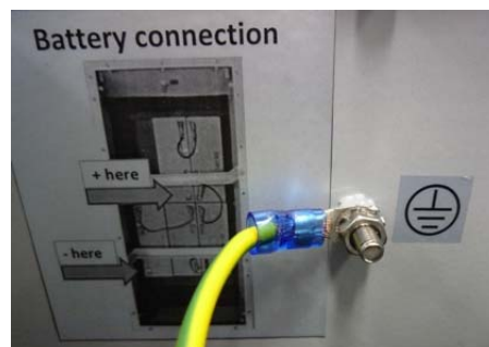
Abb. 6: PE-Anschluss im Tragekasten Unterteil
